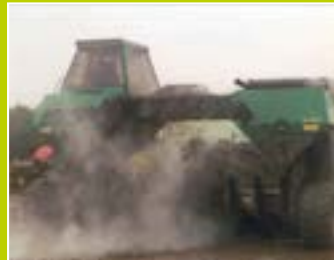
Um den Abbau zu beschleunigen, wird das gesamte Material der Dreiecksmiete von Zeit zu Zeit umgewälzt. So steht wieder genügend Sauerstoff für den Prozess zur Verfügung.
